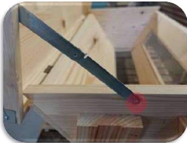
Visser la petite vis du compas dans le côté trapézoïdale sur le marquage prévu.
